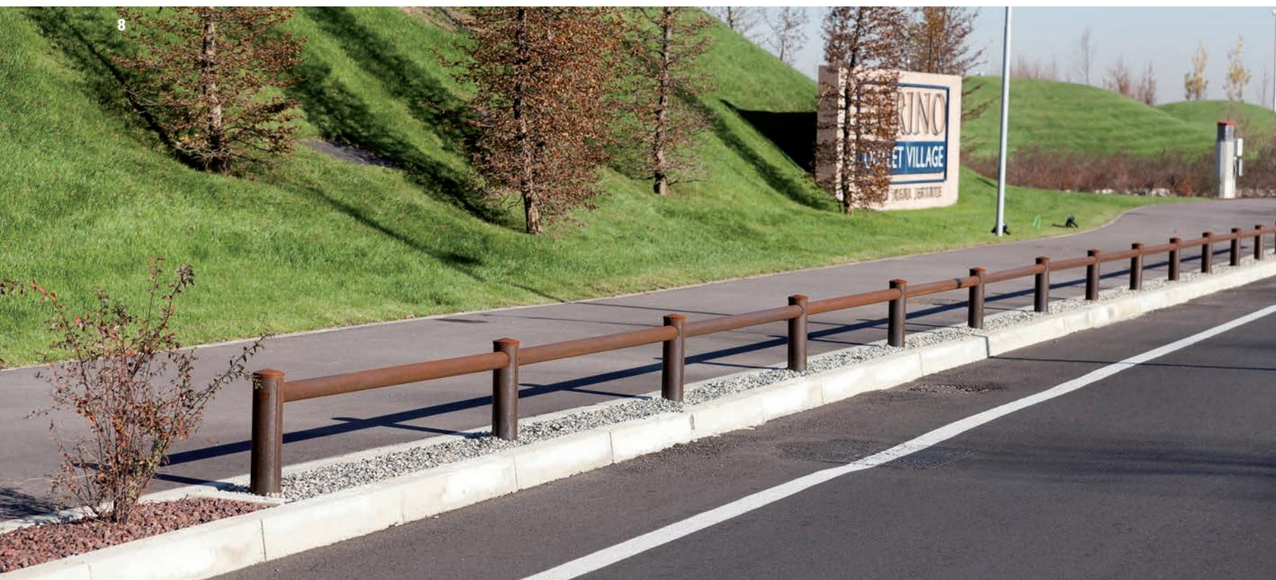
versione realizzata *ad hoc* - a un solo corrente, di altezza pari a circa 50 cm - è stata messa in funzione come elemento delimitatore di alcune aree di parking. "Questa composizione di modelli - spiega a *leStrade* Manuel Cracco, di CortenSafe - si è integrata nel modo migliore con il contesto di arredo del centro, caratterizzato da alti standard di design e valorizzazione ambientale. I riscontri sono stati molto positivi".
